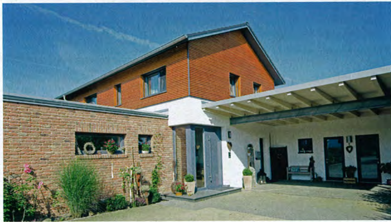
ÜBERDACHT Der großzügige Eingangsbereich dient auch als Carport.
