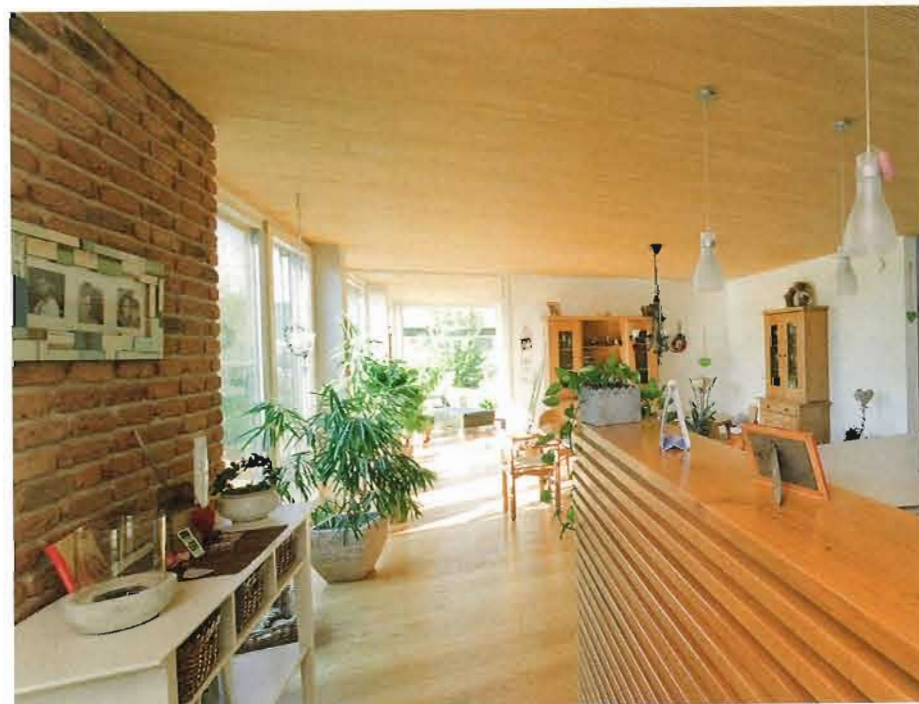
Offenes Wohnen im Passivhaus ist kein Widerspruch: Küche, Essplatz und Wohnraum gehen im großzügigen Grundriss ineinander über. Die Holzakustikdecke spannt von Außenwand zu Außenwand. So ist ein Raumerlebnis ohne tragende Zwischenwände oder Stützen möglich.
